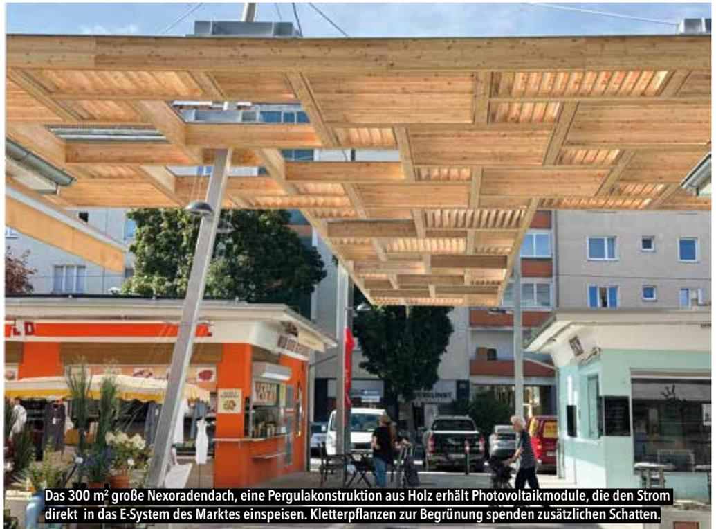
Das 300 m<sup>2</sup> große Nexoradendach, eine Pergulakonstruktion aus Holz erhält Photovoltaikmodule, die den Strom direkt in das E-System des Marktes einspeisen. Kletterpflanzen zur Begrünung spenden zusätzlichen Schatten.
